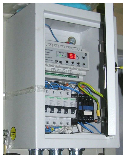
Рисунок 9б - Размещение на кожухе щитка с аппаратурой.
