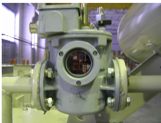
Рис. 5.5 Газовое реле
