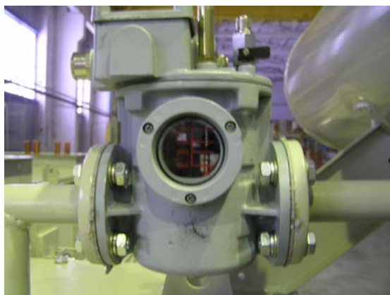
Рис. 7.10 Газовое реле С01Н
