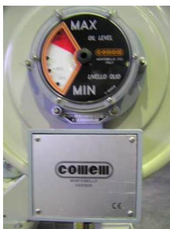
Рис. 7.2 Маслоуказатель стрелочного типа LA14
